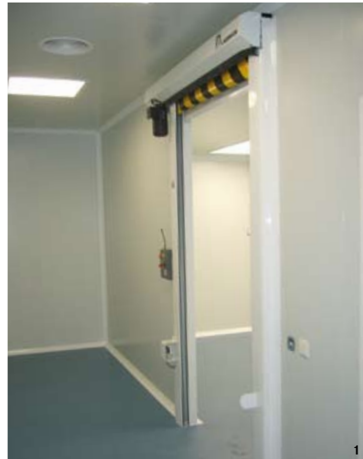
▲ SALAS BLANCAS: Sistema SAS de interconexión para aislar espacios mediante puertas dobles.
