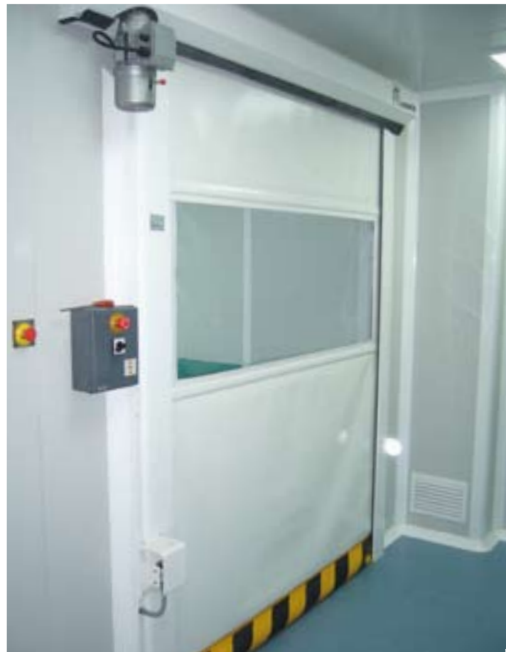
▲ SALAS BLANCAS: Sistema SAS de interconexión para aislar espacios mediante puertas dobles.
