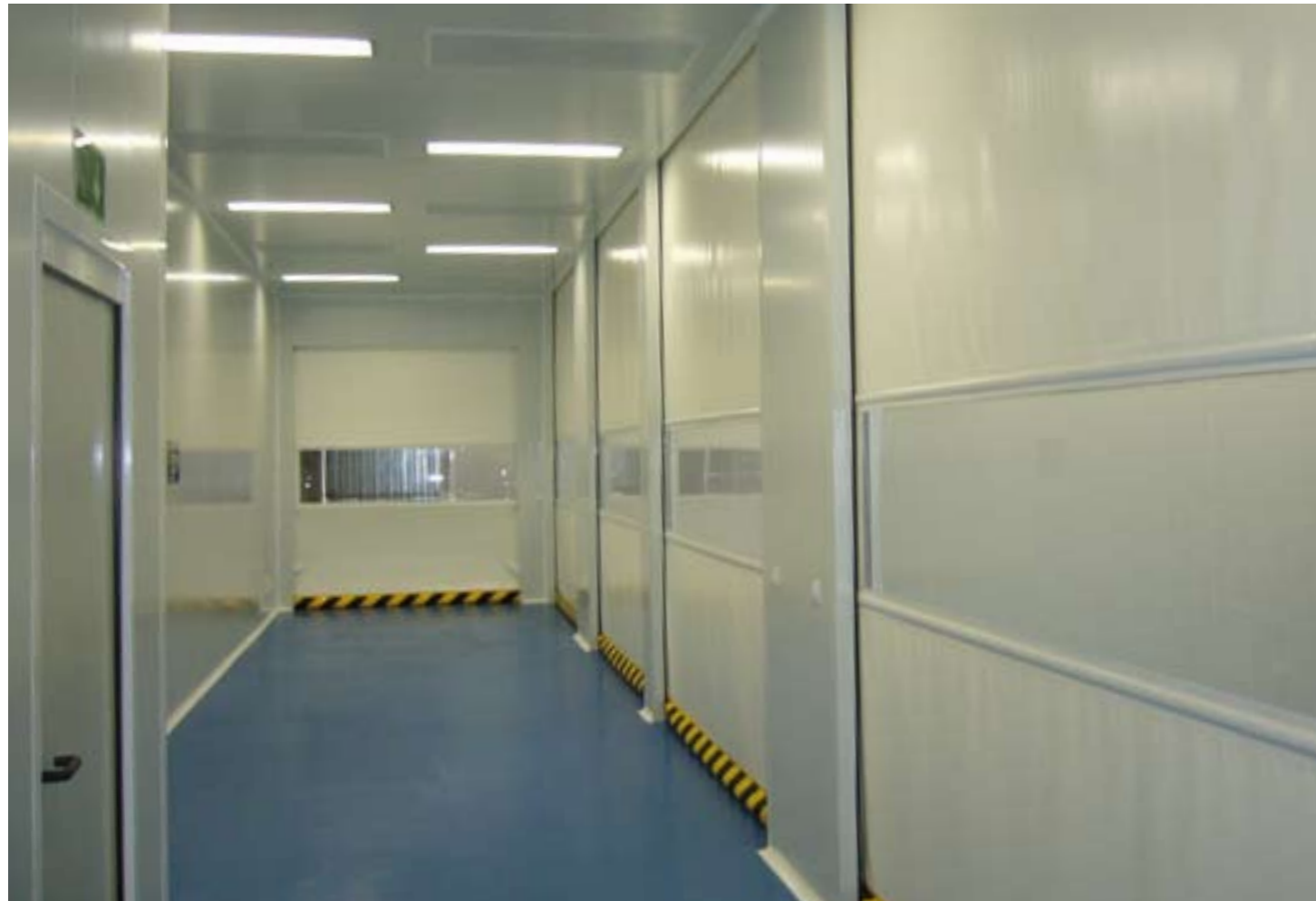
▲ SALAS BLANCAS: Sistema SAS de interconexión para aislar espacios mediante puertas dobles.
