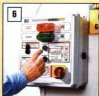
6 el ayudante del muelle de carga pulsa el botón "lock" del panel de control para activar el sistema de enganche
