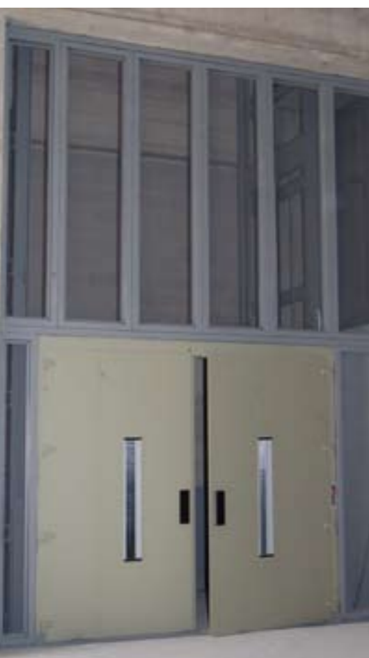
▲ Cierre mixto: albañilería y estructura
