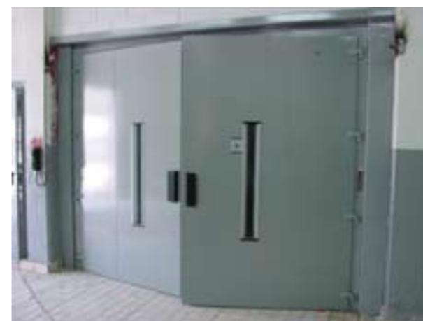
◀ Doble hoja instalación protegida.
